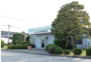
真岡工場 Moka Plant
