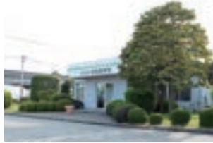
真岡工場 Moka Plant
