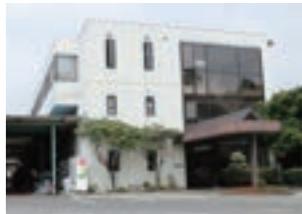
小山工場 Oyama Plant
